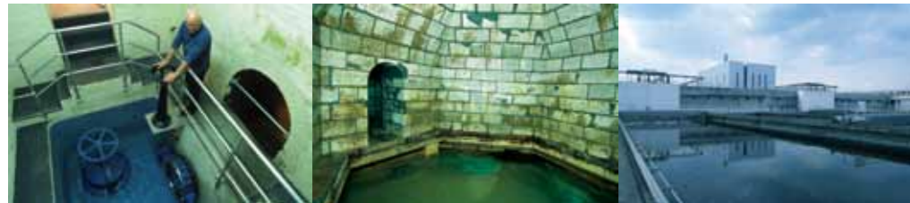
L'usine de la Jatte à Rouen
